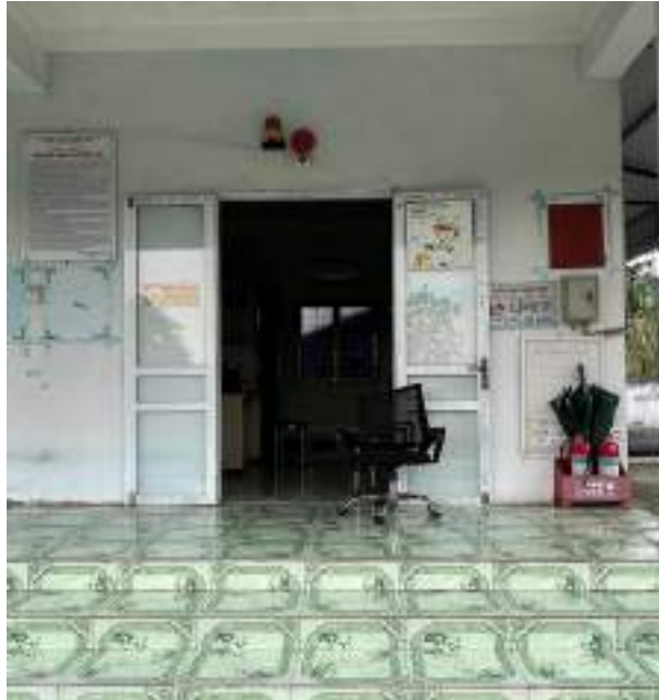
Hình 3.9. Nhà đặt thiết bị quan trắc tự động nước thải và thiết bị quan trắc của trạm xử lý nước thải mỏ than Núi Hồng
