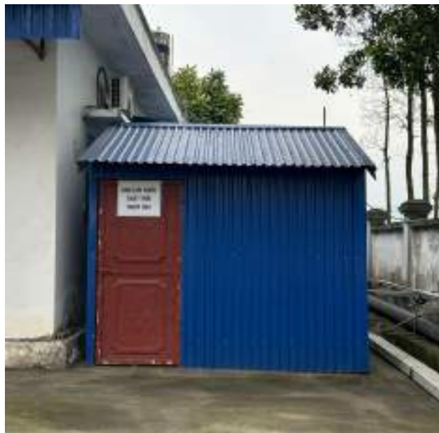
Hình 3.12. Kho chất thải nguy hại của trạm xử lý nước thải mỏ than Núi Hồng
